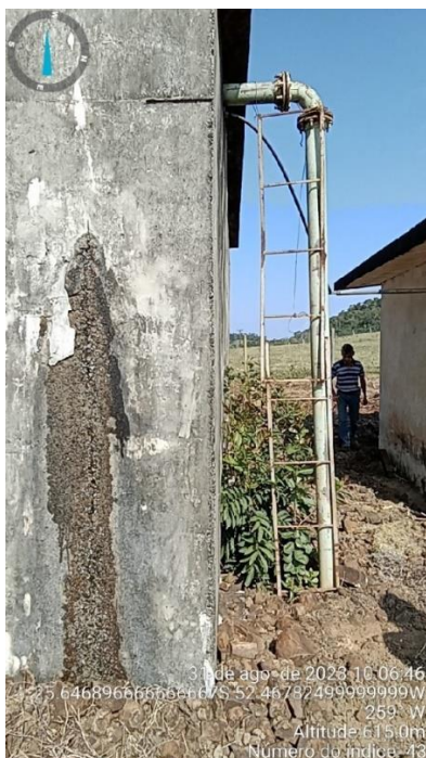
Figura 76 - Escada de manutenção
