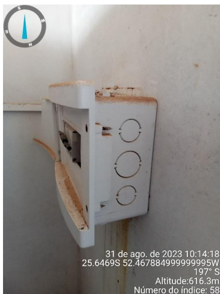
Figura 69 – Quadro de comando dosadora
