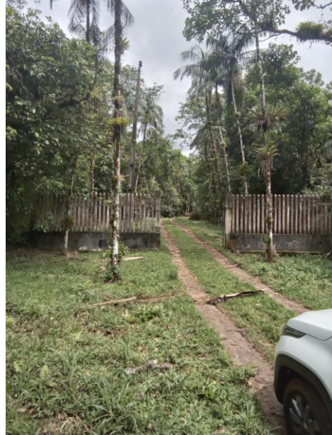
Foto 18 – Acesso captação rio Jantador
