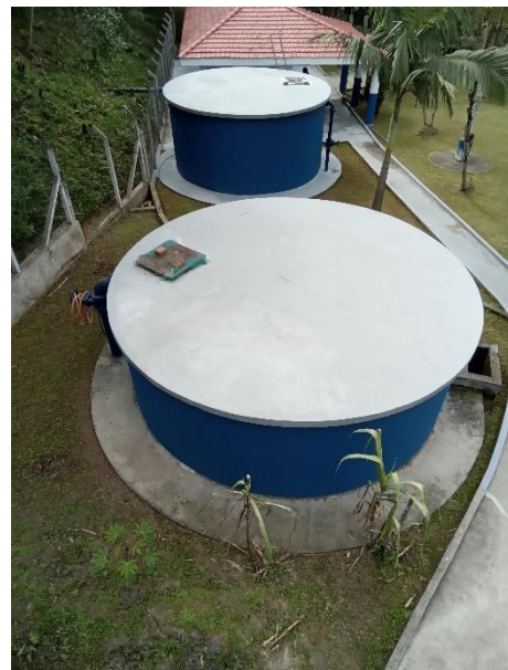
Foto 62 – RAP's ETA Itapema (RAP 1 tampa de acesso está avariada)
