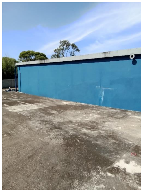
Foto 66 – Extravasador RESENT Itapema sem tela de proteção
