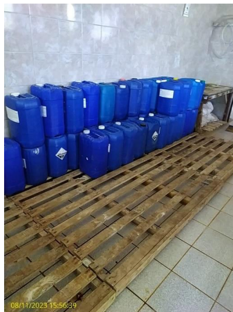
Foto 46 – Depósito produtos químicos (cloro) UTA Central
