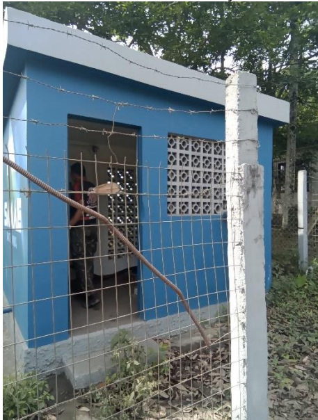
Foto 91 – Falta de identificação EEA 03
