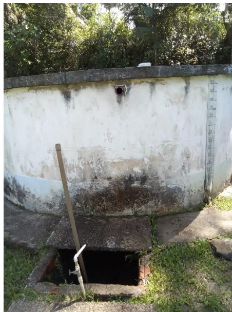
Foto 56 – Sem tela extravasador RAP Bairro Alto
