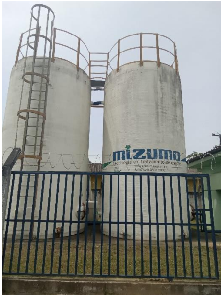
Foto 131 – Sem identificação ETE
