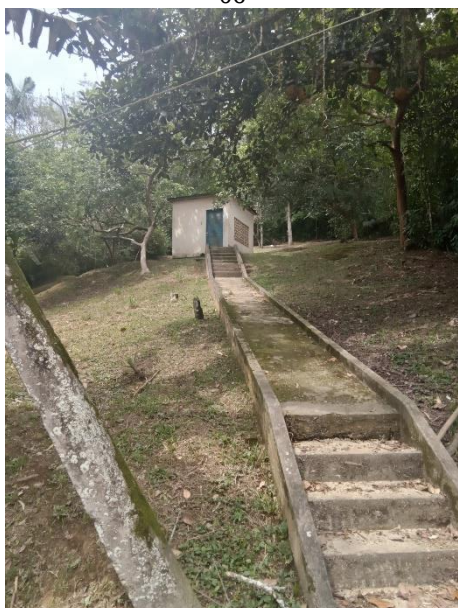
Foto 117 – Falta e isolamento e identificação EEA 06
