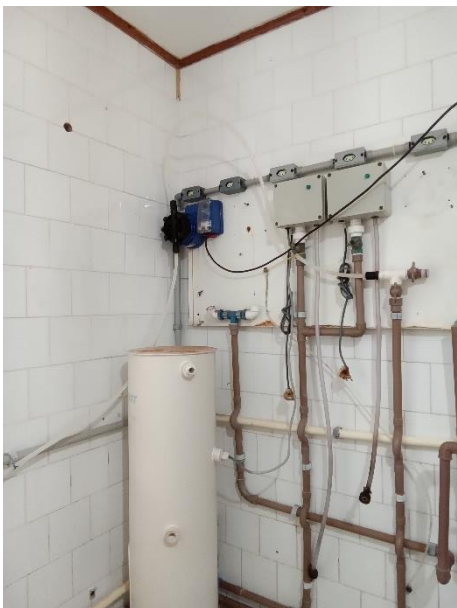
Foto 37 – Dosadoras UTA Itapema (desligadas)
