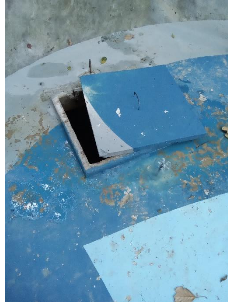
Foto 60 – Tampa de abertura RAP Penha
