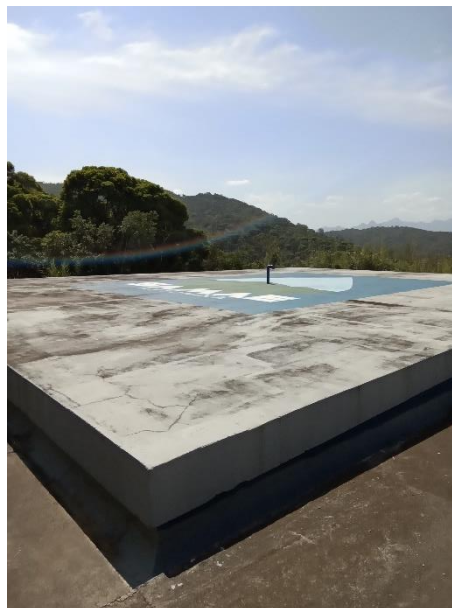
Foto 68 – Laje superior RESENT Itapema
