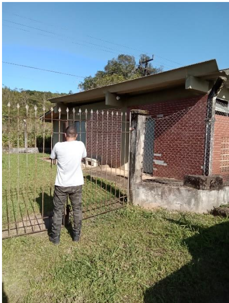
Foto 75 – Falta de identificação EEA Rios (acesso restrito/SAMAE)
