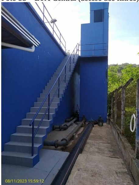
Foto 53 – ETA Central (acesso aos filtros)
