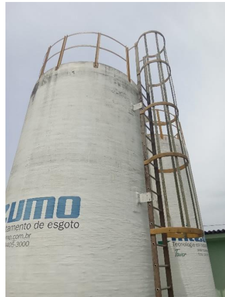
Foto 134 – Tanques anaeróbios
