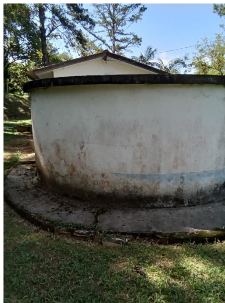
Foto 58 – RAP Bairro Alto Parte de trás
