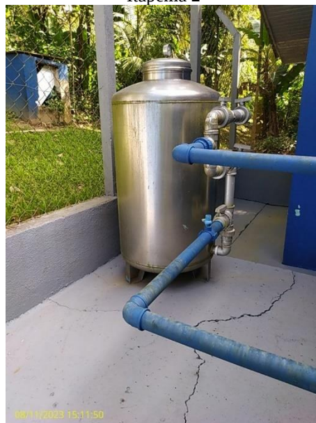
Foto 52 – Filtro portátil com fluxo descendente ETA Itapema 2
