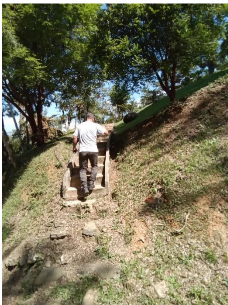
Foto 31 – Acesso UTA Bairro Alto
