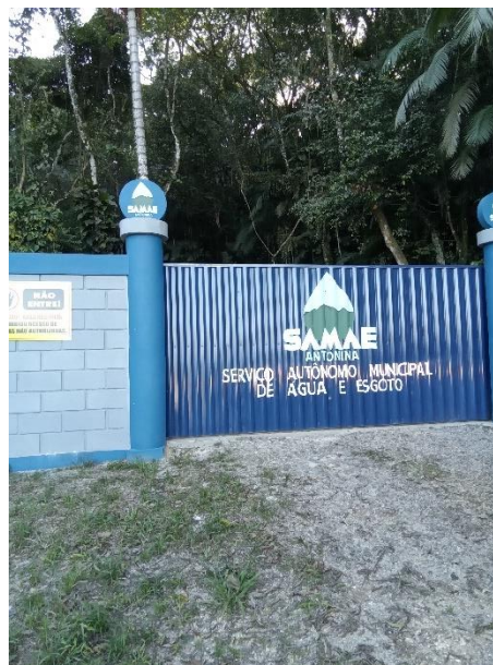
Foto 22 – Acesso Captação Penha
