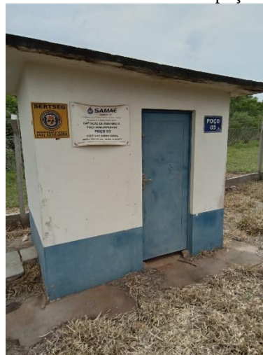
Foto 36 – Casa de comando poço 03
