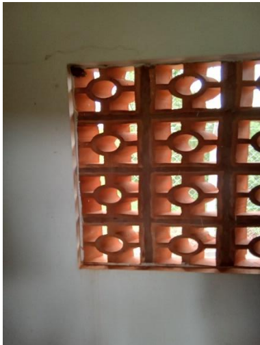
Foto 31 – Entrada de ar casa de comando
