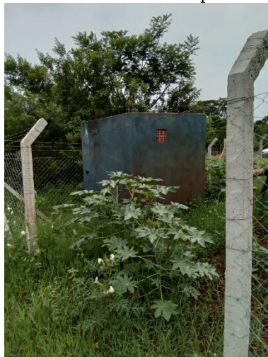
Foto 45 – Acesso sem portão
