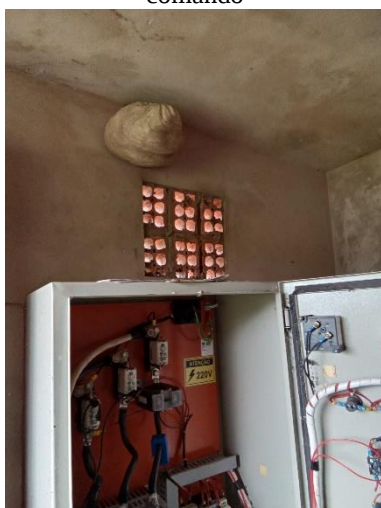
Foto 50 – Casulo de insetos dentro da casa de comando
