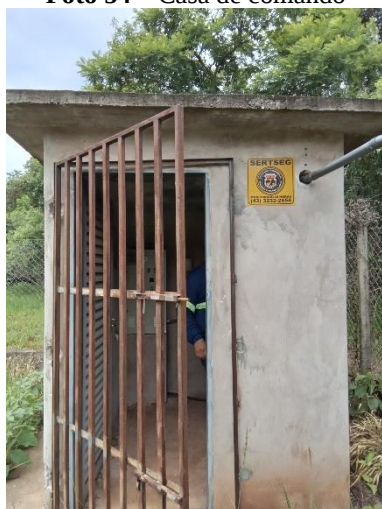
Foto 54 – Casa de comando
