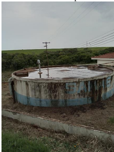
Foto 66 – Reservatório apoiado reunião
