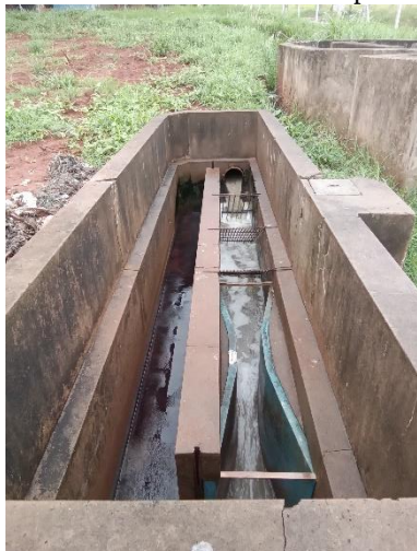
Foto 83 – Gradeamento e calha parshall
