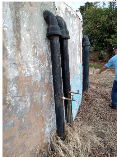
Foto 73 – Torneiras de coleta de água
