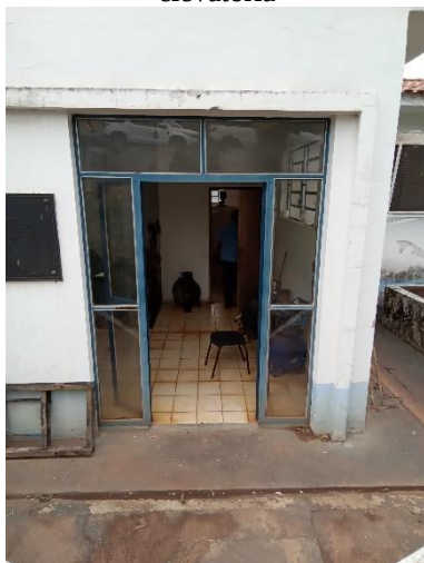
Foto 19 – Acesso casa de químicos, UTA e elevatória
