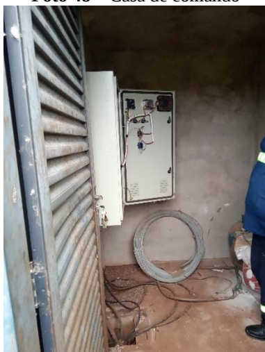
Foto 48 – Casa de comando
