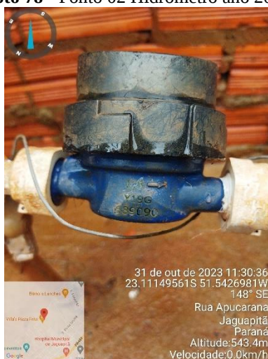
Foto 78 - Ponto 02 Hidrômetro ano 2019
