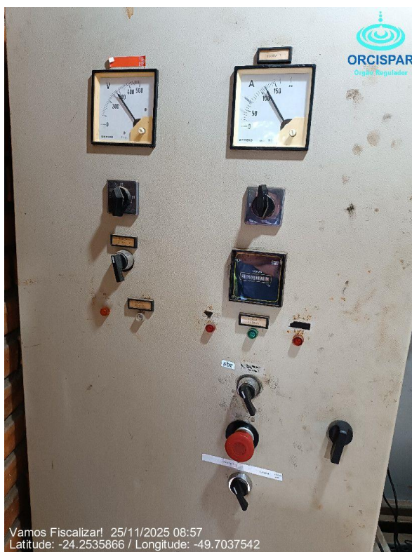
Sinalizadores do quadro sem funcionamento.
