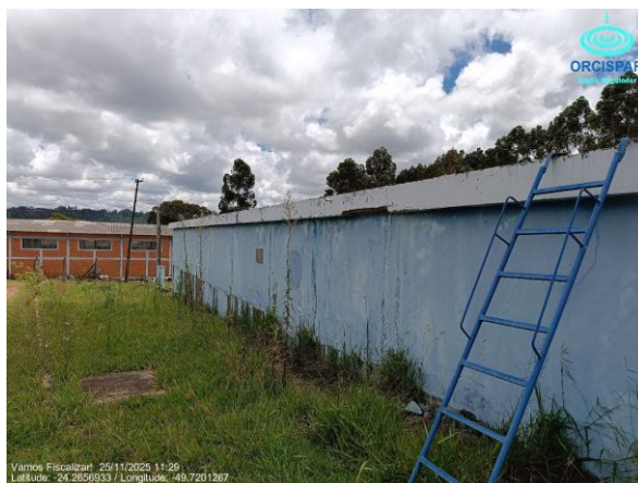
Vazamentos aparentes
