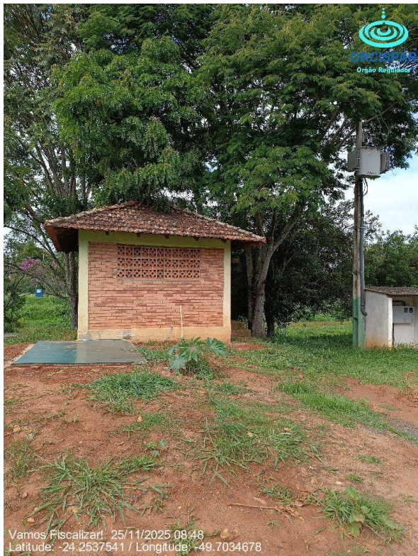
Unidade sem isolamento externo.
