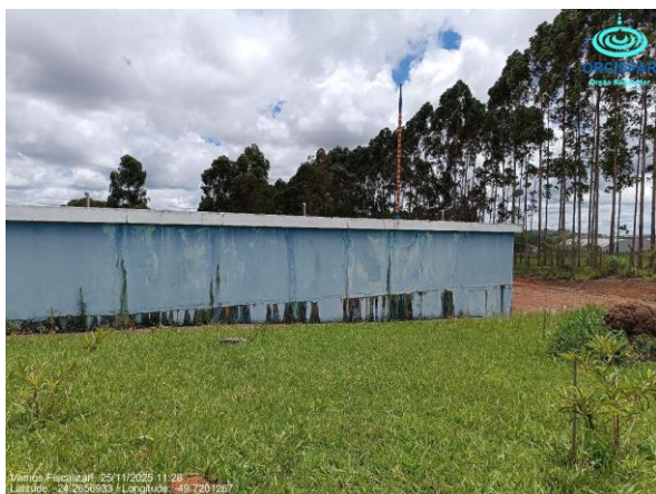
Vazamentos aparentes
