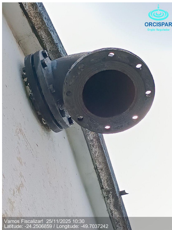
Respirador do reservatório.
